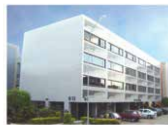
Ed. San Thiago 18 apartamentos de 2 quartos Entregue em 1993 QRSW 02 Proj. B-13
